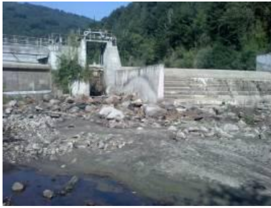
Бент и шлюзове при мини ВЕЦ близо до ГКПП Олтоманци, тесен рибен проход
